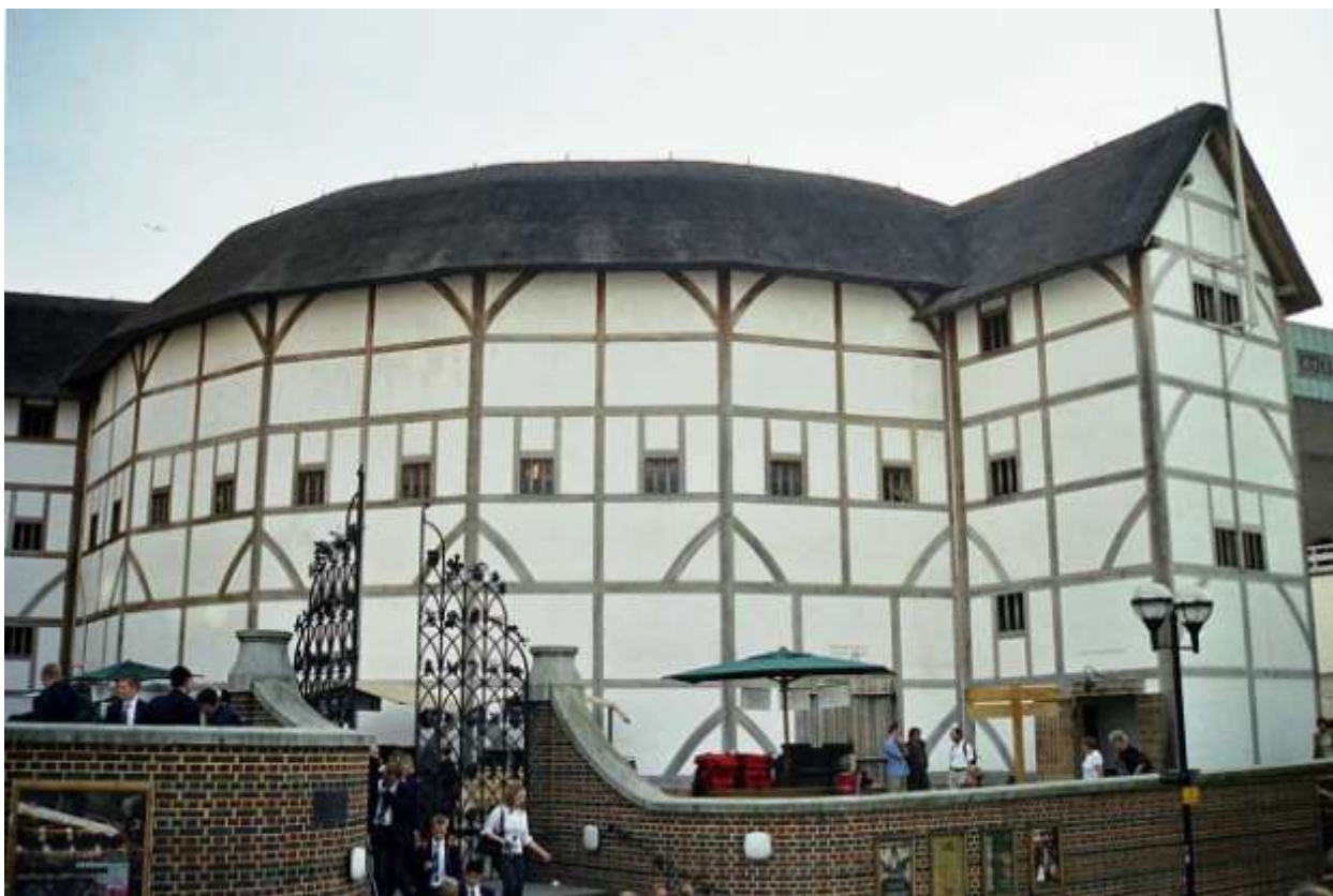
Илл. 212.1. Театр «Глобус» в Лондоне. Здание, воссозданное в 1997 году, вид снаружи.
